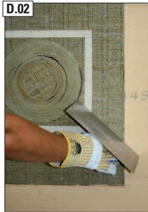
Bauseitige Wärmedämmung auf bündigen Sitz prüfen.
