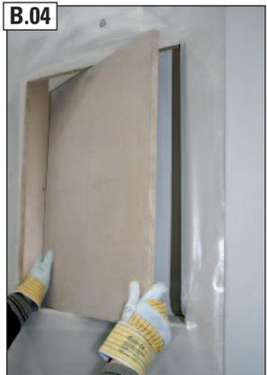
Holzwerkstoffplatten, Wärmedämmung etc. aus der Montageöffnung entfernen.
