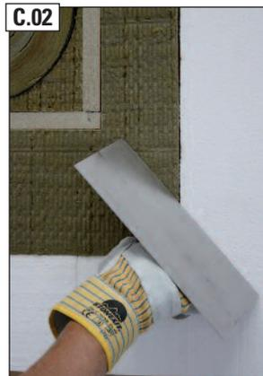
Bauseitige Wärmedämmung auf bündigen Sitz prüfen.
