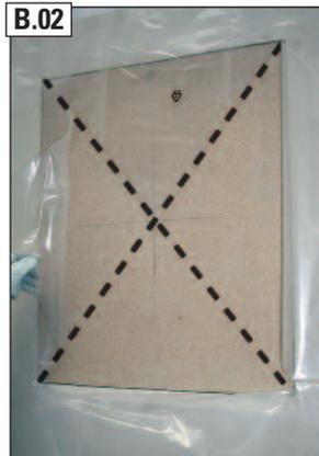
Dampfbremse kreuzförmig auf das erforderliche Öffnungsmaß (siehe Bild A.1 und A.2) aufschneiden.
