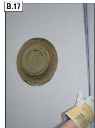
B.17 Fertige Gipskartonplatte wieder einbauen.
