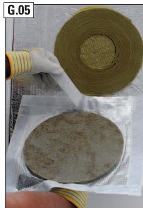
Ersten Klebestreifen entfernen. IGNIS-PROTECT Blowerdoor-Siegel so über den Innenschutzrohren ansetzen, dass der überstehende Teil der Innenschutzrohre bündig angeglichen werden kann (siehe Detailbilder G.08 und G.09).
