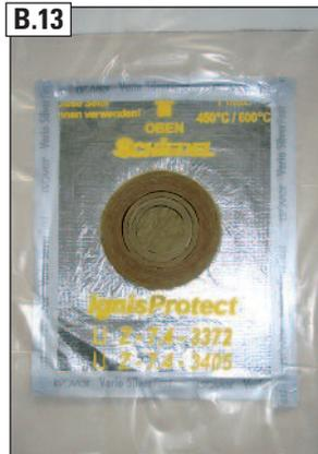
B.13 Fertigansicht der umlaufend dicht verklebten bauseitigen Dampfbremse.
