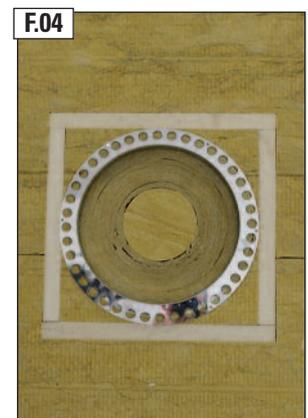
F04 Prüfen Sie vor dem Aufbringen der Pressspachtelung nochmals die korrekte zentrische Ausrichtung der Regenrosette.
