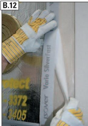
B.12 Übergänge zur Dampfbremse bauseitig mit geeignetem Dichtband auf der Alukaschierung verkleben.
