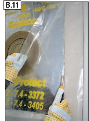
B.11 aBauseitige Dampfbremse bündig zum IGNIS-PROTECT zuschneiden.
