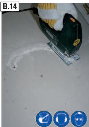
B.14 Gipskartonplatte auf das erforderliche Öffnungsmaß des IGNIS-PROTECT Außen-schutzrohres zuschneiden.
