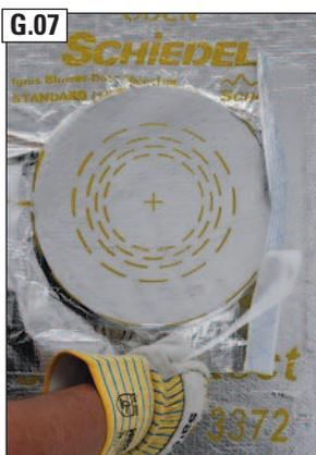
Schrittweise restliche Klebestreifen entfernen und bündig am überstehenden Teil der Innenschutzrohre angleichen.
