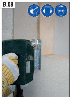
Öffnung gegebenenfalls nacharbeiten. Wärmedämmung um die Montageöffnung im Ständerwerk wieder vollständig herstellen.
