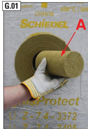
Der mitgelieferte IGNIS-PROTECT-Montageverschluss (A) verbleibt bis zur Montage der bauseitigen Verbindungsleitung im innersten Innenschutzrohr!
